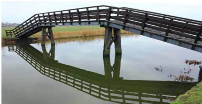
(Foto: voorbeeld brug tussen De Ljepper en de Hounsdyk)
